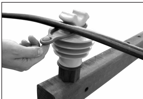
5.1 Posicione o Anel de Amarração e o Conductor lateralmente no pescoço do Isolador.
