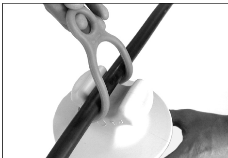
4.1 Posicione o Anel de Amarração no do pescoço do Isolador.
