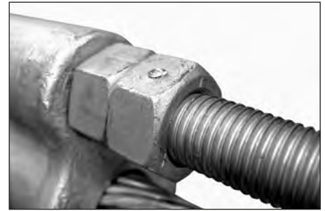
14. Porca anti-vandalismo totalmente aplicada.
