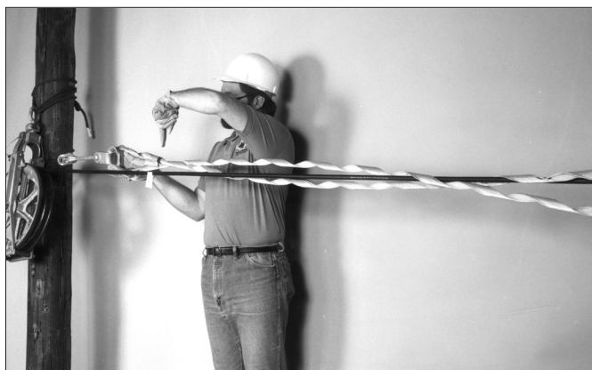
Figura 2 - Posicionamento da Alça Preformada.
