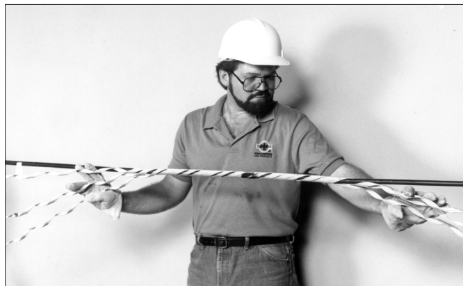
Figura 7 - Completando a aplicação do SRR.
