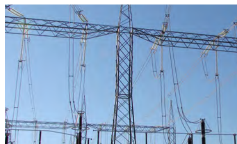
Cadeias instaladas ao Pórtico
