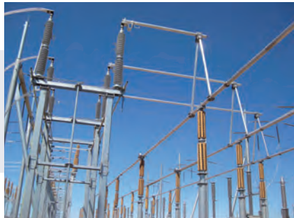
Subestação em construção com Sistema de Barramento PLP
