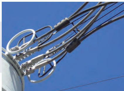
Conectores Paralelos Aparafusados
