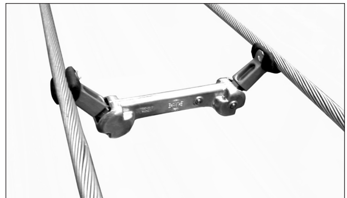
2. Posición correcta del cuerpo del espaciador, perpendicular al haz de conductores.
