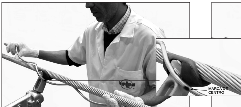
3. Posicione la marca de centro de la varilla sobre el extremo redondeado de la cubierta de elastómero. Asegúrese que la varilla preformada envuelve entre el brazo y la saliente interna.
