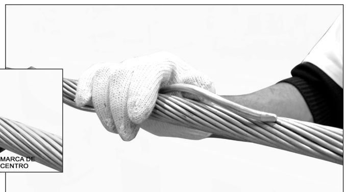
4. Aplique la varilla sobre el conductor, observando que sus extremos deberán posicionarse en la parte interna del haz.
