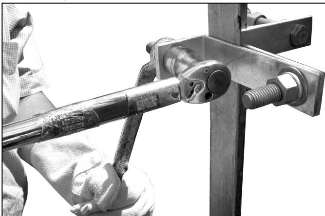
4.2.5 El torque especificado para los tornillos 5/8" del Soporte es de 8 kg.m.
