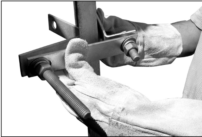
4.2.1 Afloje el tornillo de la chapa "L" y posicione el Soporte en el montante de la torre.
