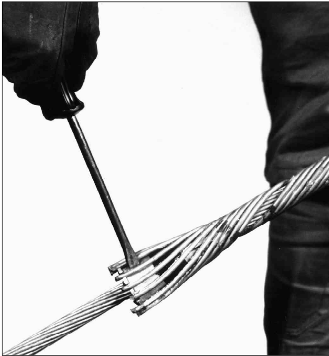
9. Terminada la aplicación de los subconjuntos de Varillas Preformadas, utilice un destornillador para colocar cada Varilla en su correspondiente muesca de la Cuña.
