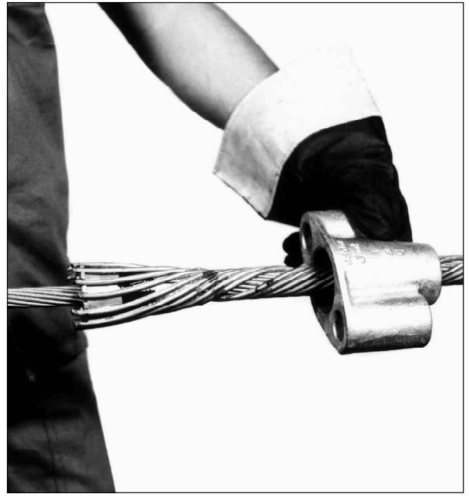
10. Verifique si las Varillas están perfectamente encajadas en las muescas, suelte la Cápsula de la fijación provisoria y encaje firmemente sobre la Cuña.
