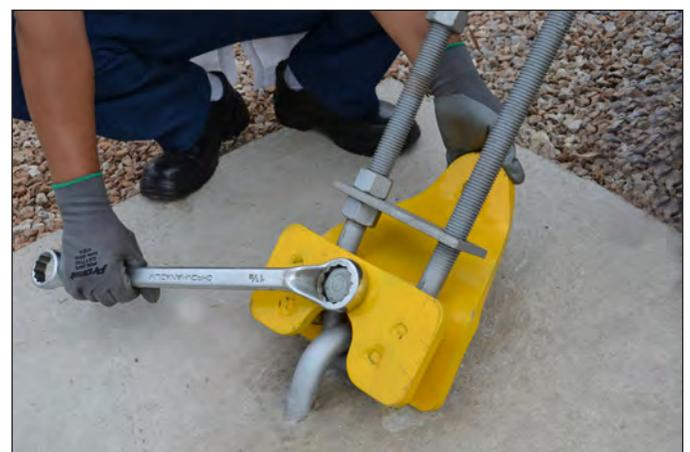
4. Insira o parafuso no Dispositivo e aperte-o com uma chave de boca.
