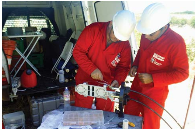
Equipe da Schahim trabalhando na Caixa FibreGuard.
