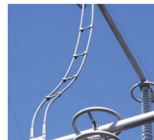
Espaciadores de Conductores
