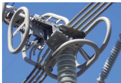
Conjunto de Anillos de Protección
