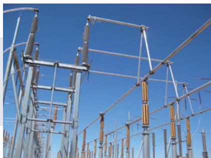
Subestación en construcción con Sistema de Barras PLP
