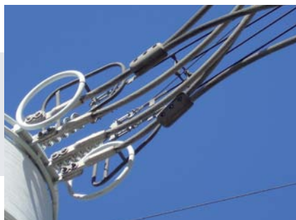
Conectores Paralelos Abulonados
