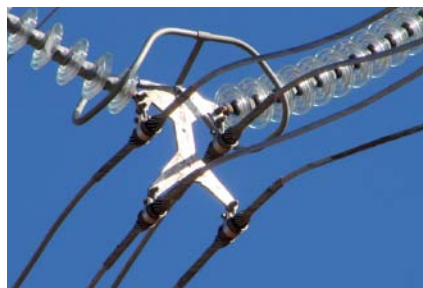
Cadena de Suspensión en V
